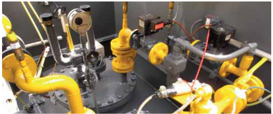
Die Anlage zeigt sich nach Abschluss der Arbeiten rundumsaniert.
